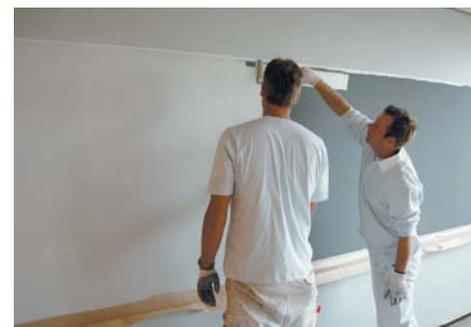
En cas de support non pierreux, doublez le temps de séchage également. Nous vous conseillons d'utiliser une peinture murale ou une laque satinée à base aqueuse en guise de couche de finition. Ce type de peinture est plus résistant, lavable et permet d'éviter les dégradations prématurées du support. Si vous optez pour une autre finition, veuillez préalablement nous contacter pour des conseils techniques.
