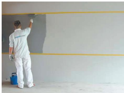
Entre deux couches, recouvrez le bac à rouleau et emballez le rouleau dans un sac en plastique pour éviter qu'il ne sèche.
